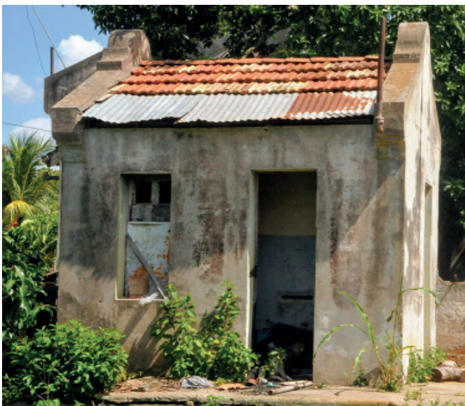
Una estructura adyacente al andén fungía como baño de la instalación.
