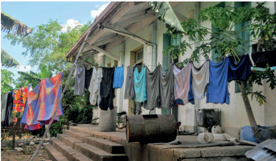
Las transformaciones hechas al inmueble (convertido en una vivienda dividida), no ocultan completamente los elementos de su estilo arquitectónico.
