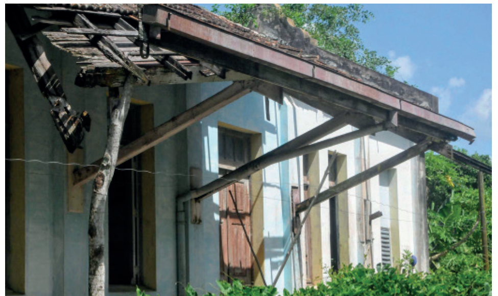
Su cubierta a dos aguas de tejas francesas sufre los avatares del tiempo.
