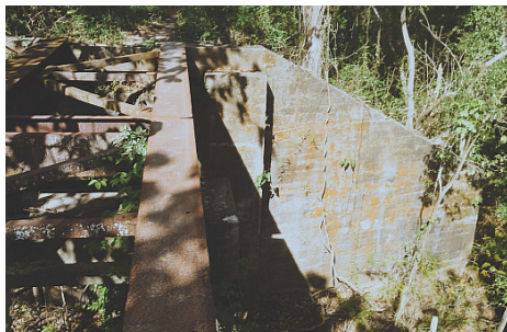
Costado donde aparece la posible fecha de culminación de la obra.
