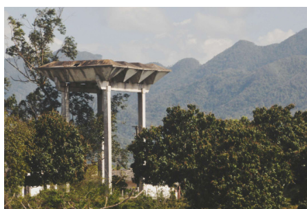
Infraestructuras de diversas vaquerías pueblan la zona.
