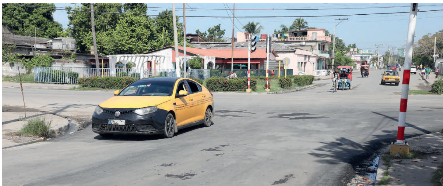
Una calle fundamental de Cienfuegos, como la 63, que alcanzó un lamentable estado, recuperó su esplendor asfáltico.
