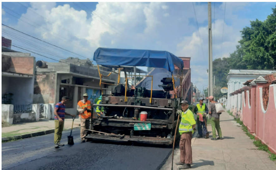
Pavimentación en áreas cercanas al Hospital Pediátrico Provincial.
