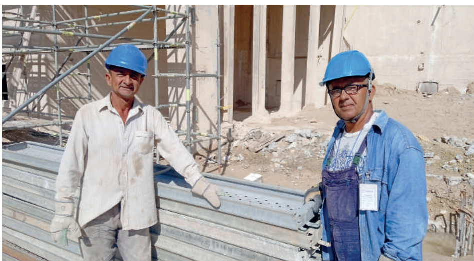
De izquierda a derecha, Nerio Martínez y Ángel Espronceda, trabajadores de la construcción que laboran en el electrofiltro de Cementos Cienfuegos S.A. / Fotos: del autor
