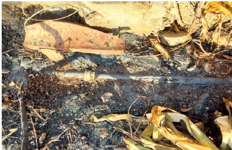
Daños ocasionados a la acometida de un vecino. / Fotos: de la autora
