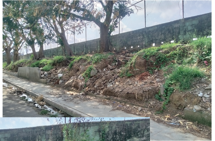
El muro que bordea la calle por el lateral de la pista no fue terminado, y una parte se derrumbó.
