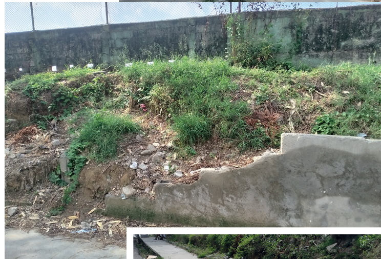
El muro que bordea la calle por el lateral de la pista no fue terminado, y una parte se derrumbó.
