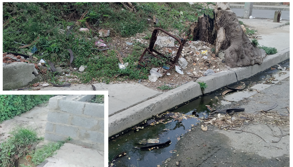
En Dorticós e Industria, la caída de un árbol removió la acera, levantó el contén.
