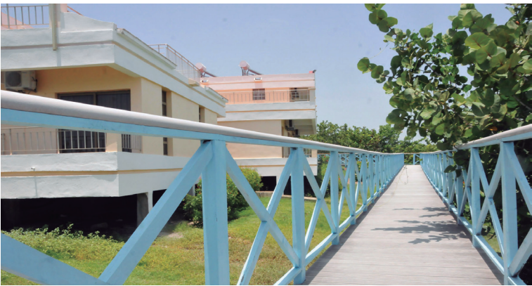
La moderna pasarela del hotel Faro Luna permite el acceso de los huéspedes a las zonas de baño y al Delfinario.
