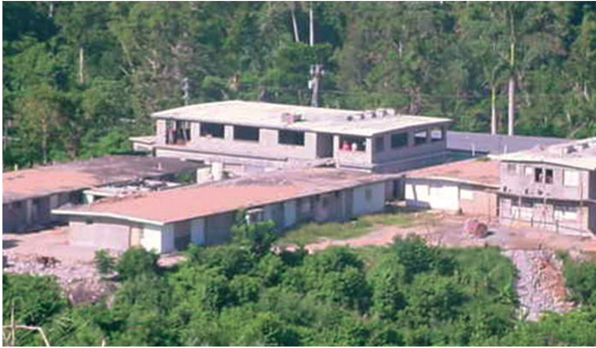
Policlínico Rural San Blas, Cumanayagua, una de las obras asumidas por la ECGO. / Foto: cortesía de la Empresa
