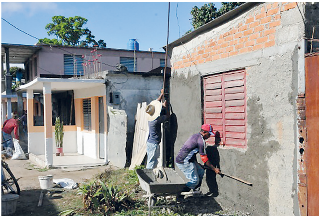
En la provincia, más de mil 500 viviendas de comunidades vulnerables serán beneficiadas con acciones constructivas. / Foto: Dorado
